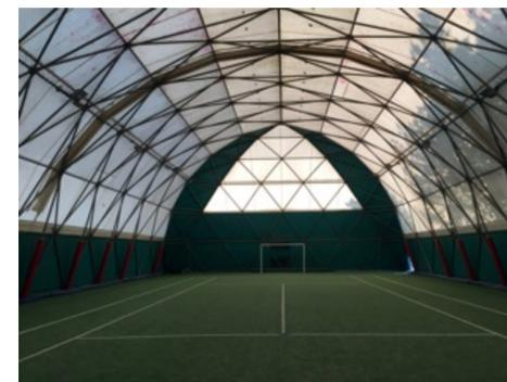
6 - INTERNO STRUTTURA GEODETICA
